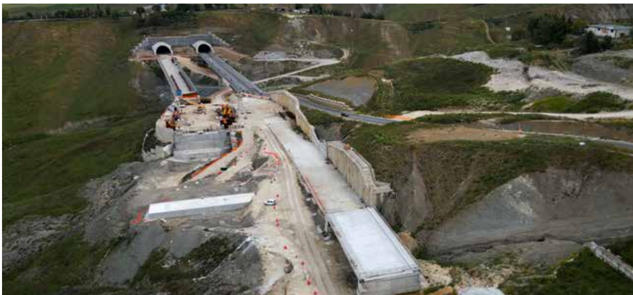
Cantiere di Ferroberica: S.S. 640 Caltanissetta - Agrigento con galleria
