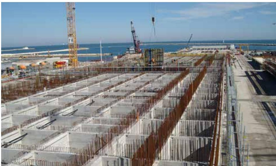
*Venezia, bocca di porto di Malamocco. Realizzazione delle strutture che costituiscono la base per le barriere del Mose per la difesa di Venezia dalle acque alte. Attualmente le quattro barriere sono completate*
